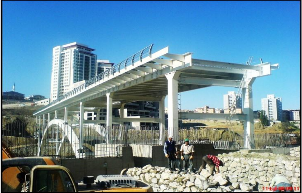
Korkuluk ve kompozit döşemelerin montajı
