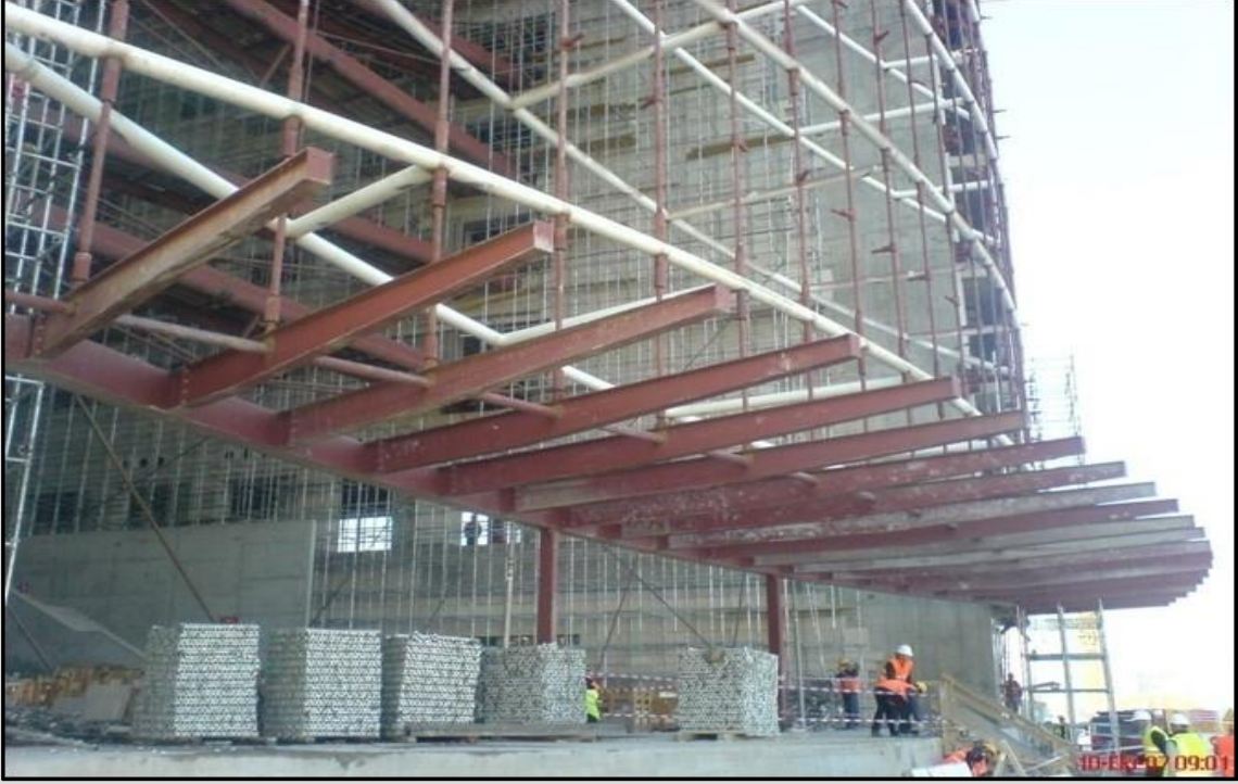
Kuzey Cephe Giriş Kanopisi
