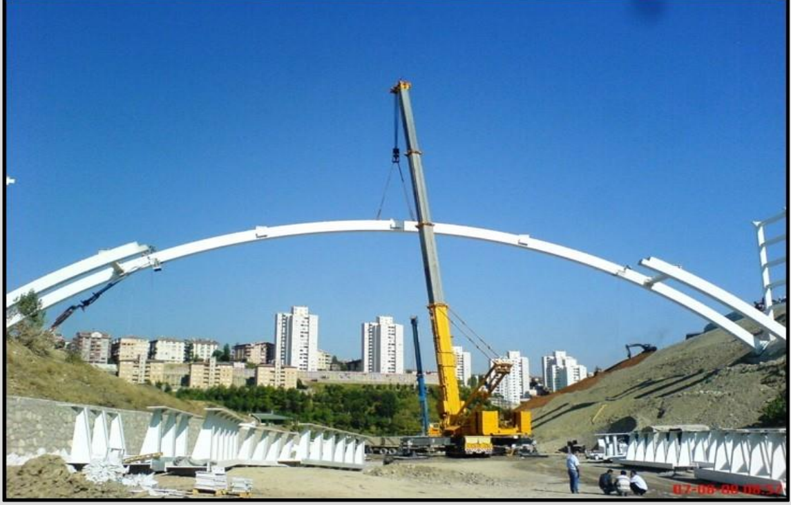
Kemerlerin 800 tonluk vinç ile montajı
