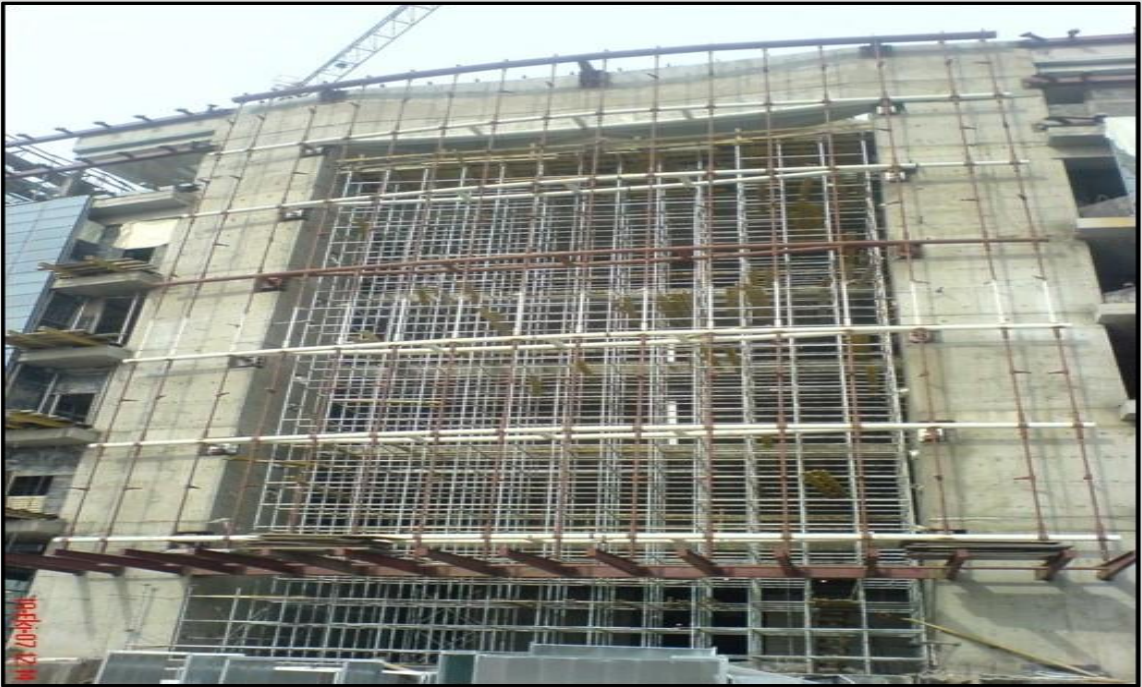
Güney Cephe Görünüşü
