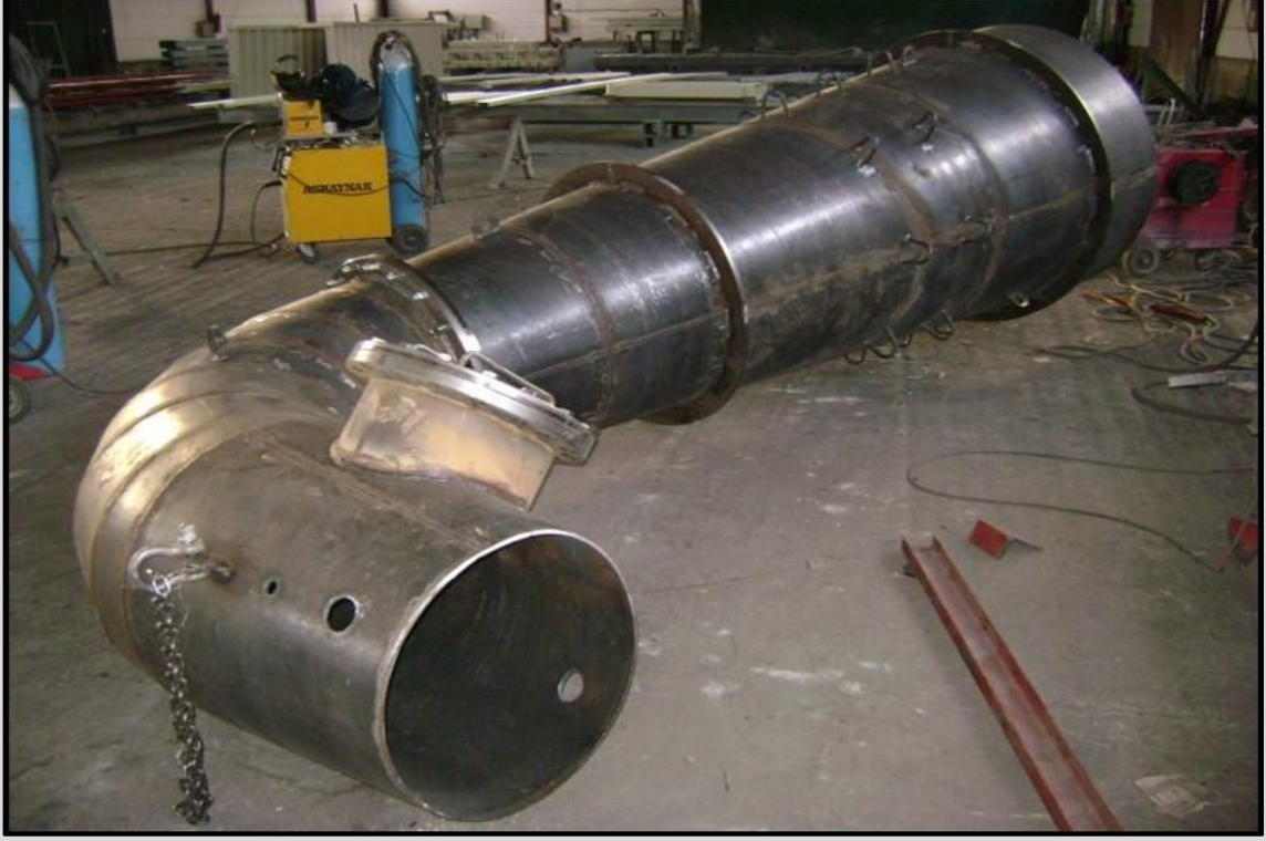
Draft Tüplerin Fabrikada İmalatı
