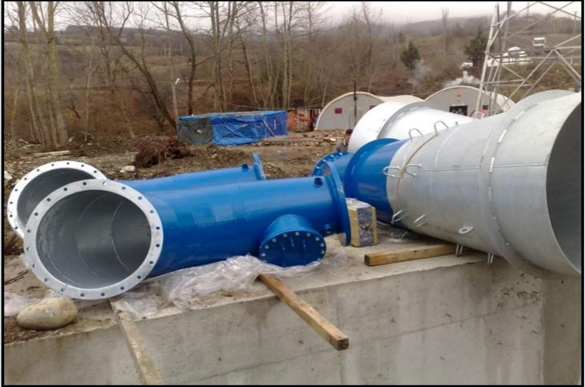
Draft Tüplerin Sahada Montajı
