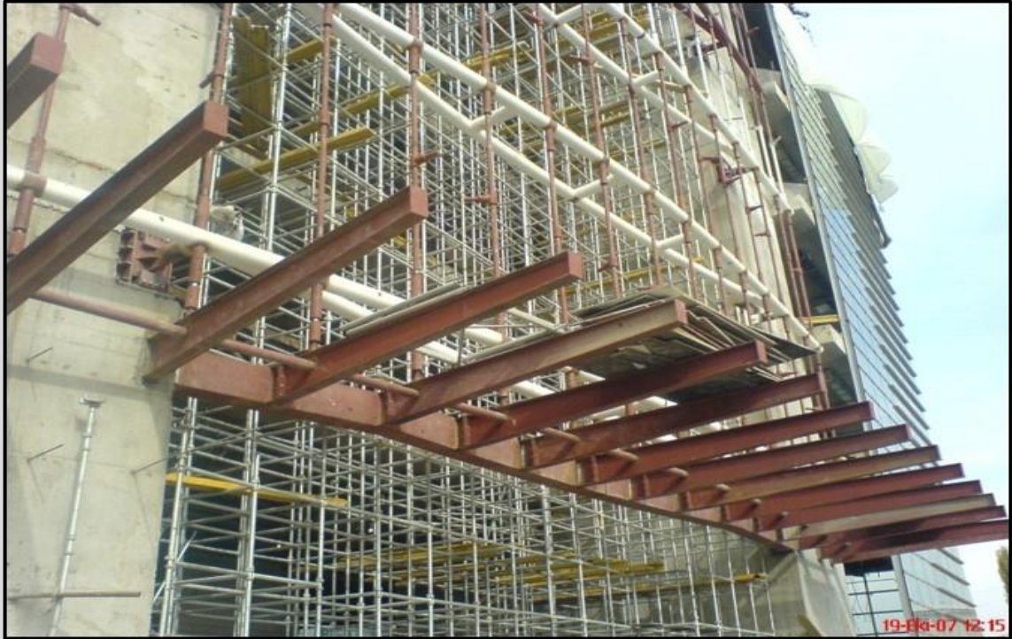
Güney Cephe Giriş Kanopisi
