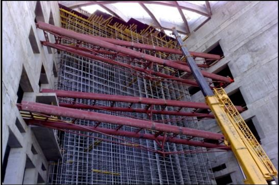
25 m uzunluğunda ve 20 ton ağırlığında atrium köprüleri
