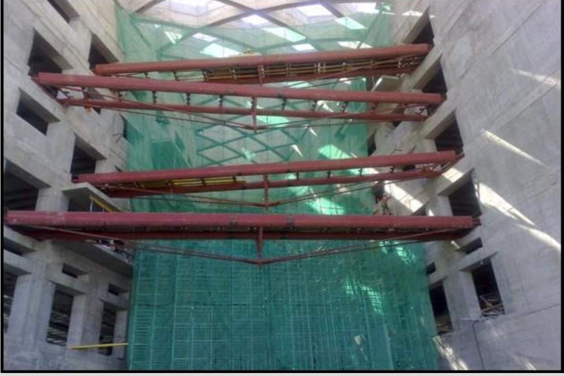
25 m uzunluğunda ve 20 ton ağırlığında atrium köprüleri
